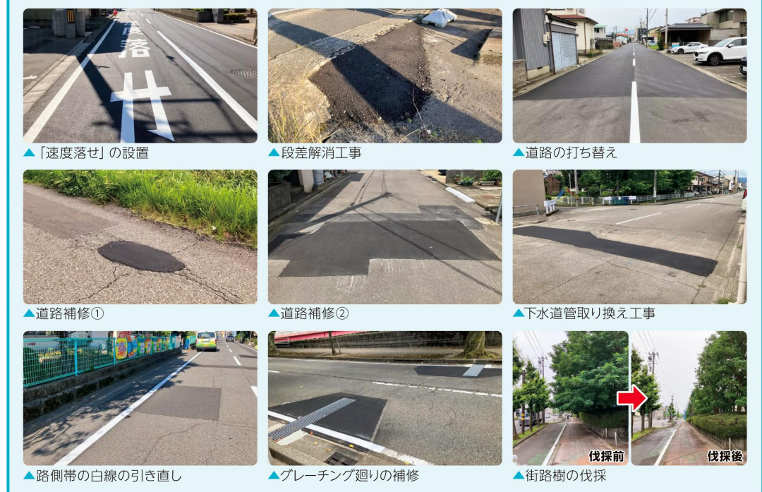
▲「速度落せ」の設置 ▲段差解消工事 ▲道路の打ち替え ▲道路補修① ▲道路補修② ▲下水道管取り換え工事 ▲路側帯の白線の引き直し ▲グレーチング廻りの補修 ▲街路樹の伐採 伐採前 伐採後
