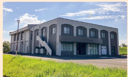
▲防災ステーション(土橋町) [拠点備蓄施設の一つ]
