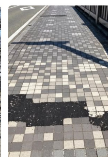
▲道路の補修①
