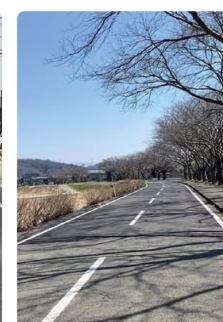
▲道路の打ち替え
