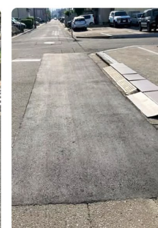
▲道路の補修③
