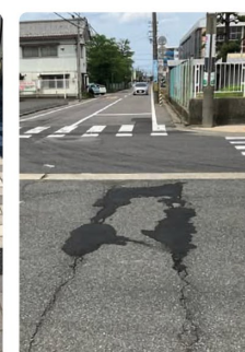
▲道路の補修②
