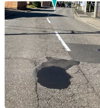
▲陥没の補修
