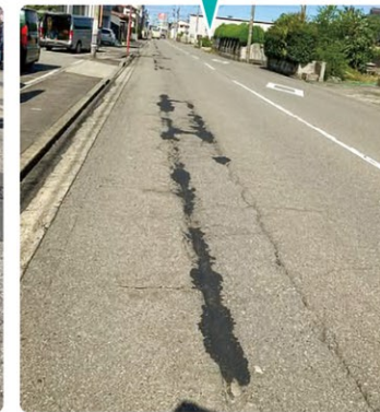
▲道路のひび割れ補修
