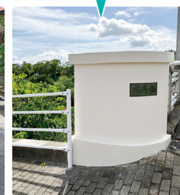
▲花月橋の補修
