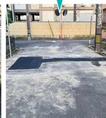
▲漏水箇所の補修
