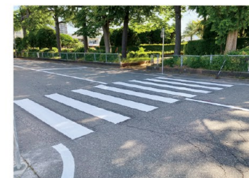
▲交通量の多い公園前の道路に横断歩道を設置してもらいました
